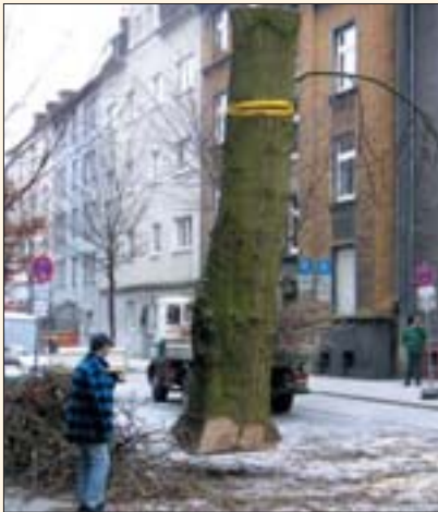
Auf der gesperrten Straße wurden die über die Dächer gehobenen Baumteile zerkleinert und abtransportiert.
