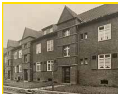
Der Markgrafenhof war eines der ersten vier Häuser der Genossenschaft.
